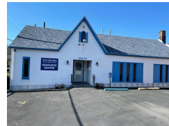
Transition 2 Hope 217 S. Washington St. Du Quoin, IL 62832
